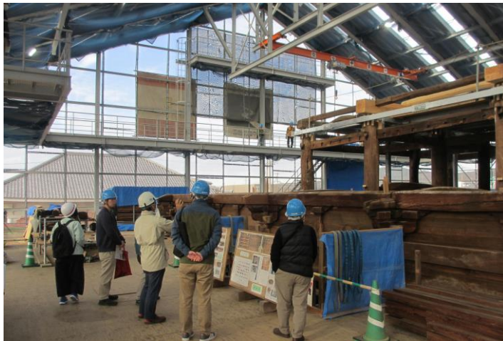
▲11/26 願興寺本堂修理工事現場見学会
