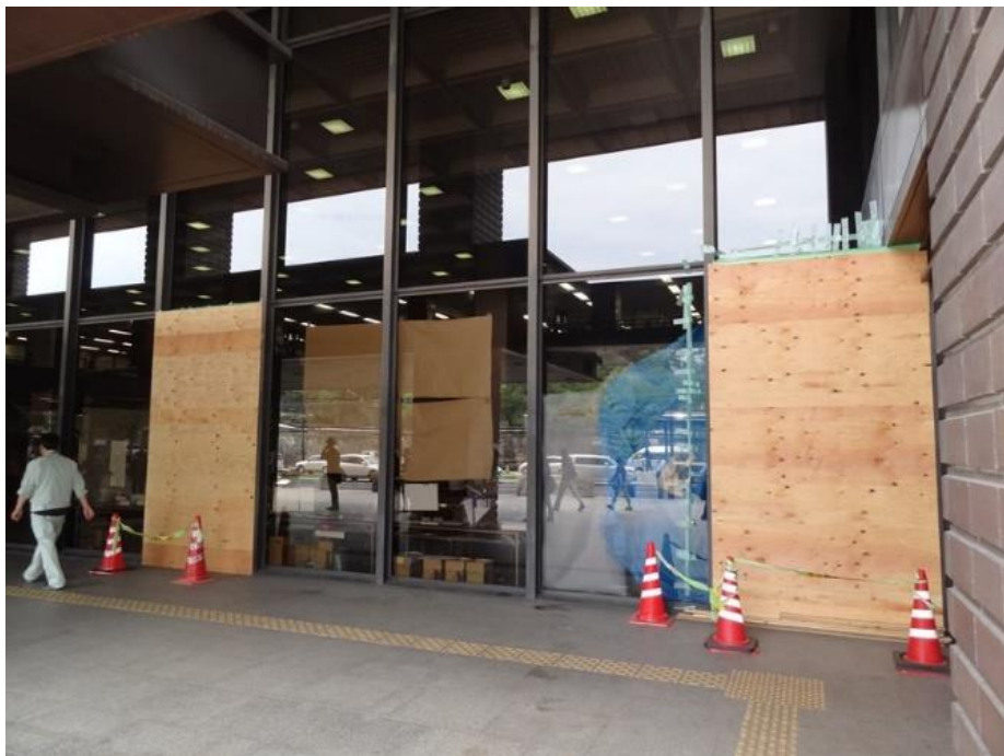
熊本市役所の被災の様子(平成28年5月27日)
