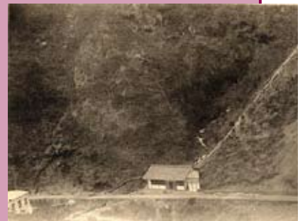
▲ コンクリート水圧管と発電機械室
